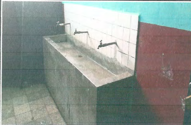
Foto 3: Remozamiento de servicios Sanitarios
