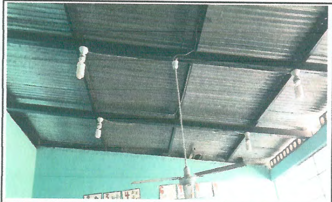
Foto 2: Remozamiento de Luz Eléctrica de 2 aulas y cocina.
