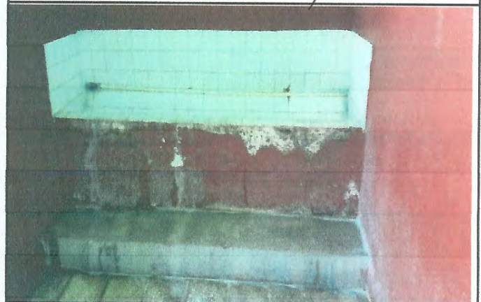
Foto 4: Remozamiento de servicios Sanitarios.
